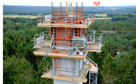
Der Aussichtsturm im Baumwipfelpfad Heide Himmel in der Lüneburger Heide. Für die Schalung des Schachts wurde die Wandschalung LOGO.3 in Kombination mit dem Klettersystem 240 zur Kletterschalung.
