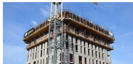
Hotelneubau in Lörrach. Die Ecklösungen der Kletterschalung sorgen für Sicherheit in 63 Meter Höhe.
