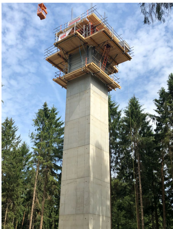
Sicher, schnell und exakt mit 14 Betoniertakten auf 44 m Höhe geklettert.
